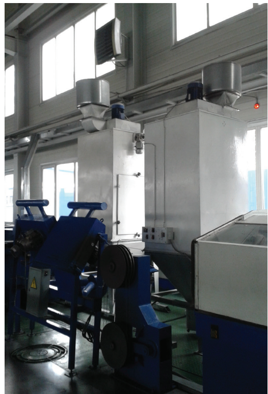
АОУМ-4000 Производство оптического волокна
